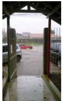
Água da rua alagou CMEI Vila Macedo, no Cajuru
